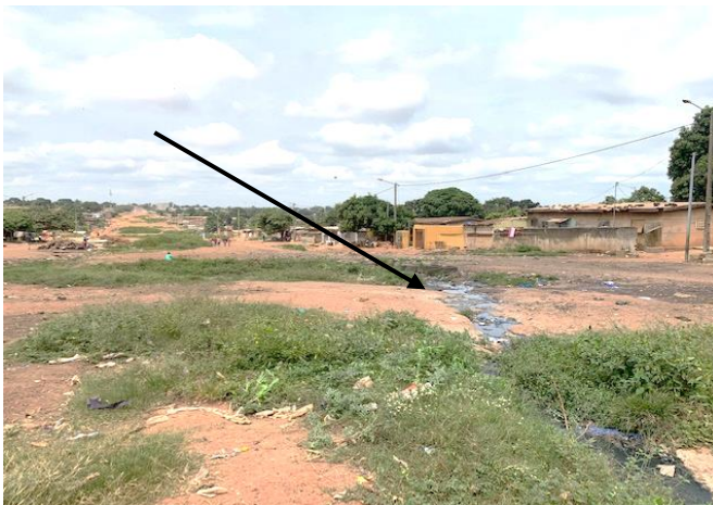
Photo 2 : Eau de ruissellement observée devant le centre de soins infirmier « Yidja »
