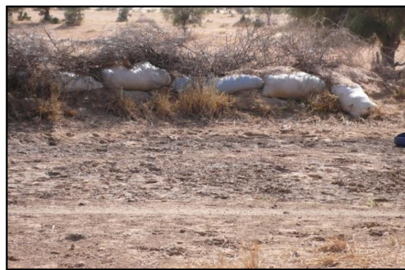
Photo 3: Digue temporaire (sacs de sable) destinés au stockage de l'eau et protection des cultures
