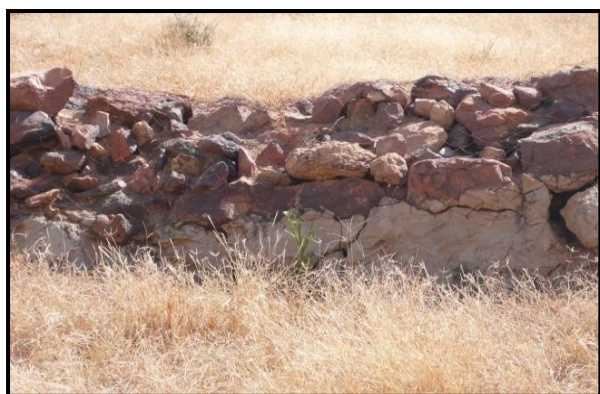
Photo 2: Cordons pierreux destinés au stockage des eaux de pluies
