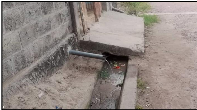
Photo 8: Évacuation des eaux usées dans un caniveau au quartier Nzoko
