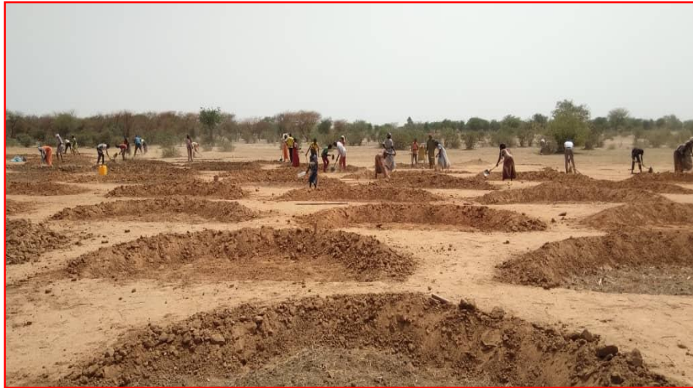
Photo 1. Construction des demi-lunes, barrière aux ruissellements
