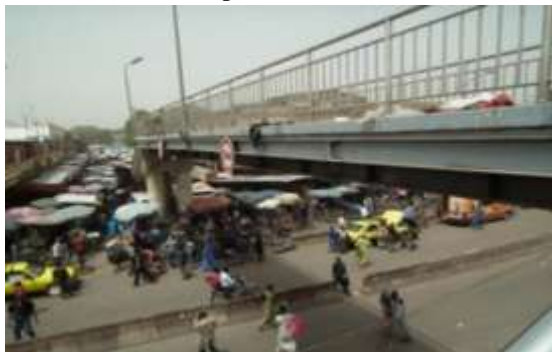
Photo 3: Passerelle piétonne au Grand marché
