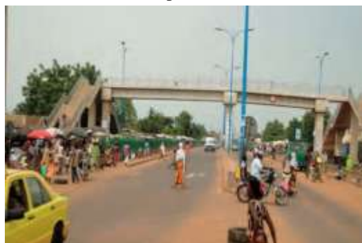
Photo 4: Passerelle piétonnes à Sébénikoro
