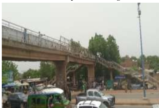
Photo 2: Passerelle piétonne à Sogoniko
