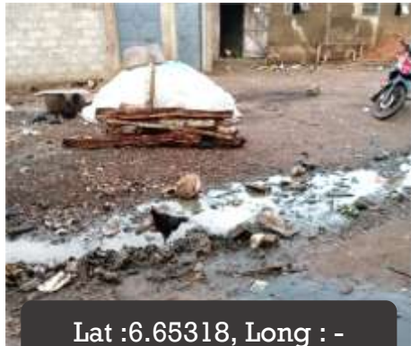
Photo 1 : Présence d'eau usée stagnante dans unité de transformation de manioc
