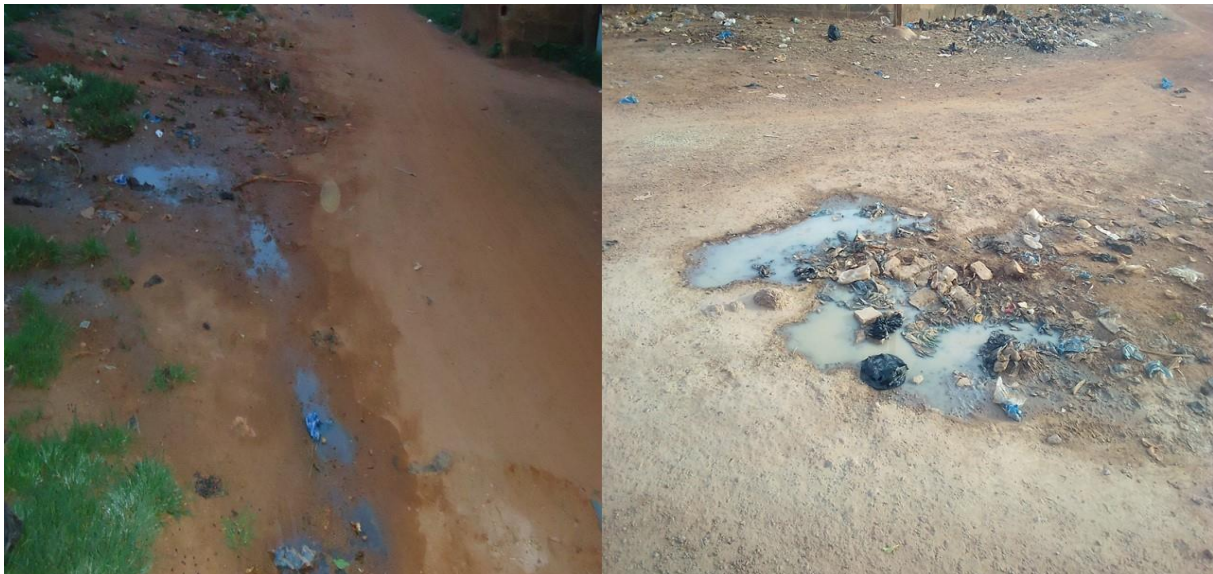
Photo 3 : Mode d'évacuation des eaux usées à marcoussis
